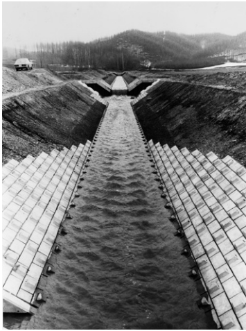
改修工事が進んだ川
