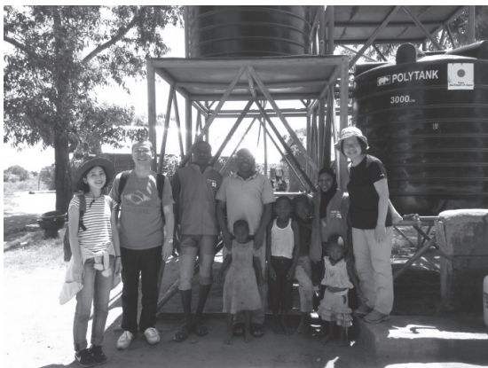
写真6 ポリグル社が設置した給水施設
