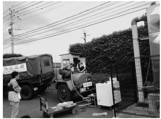
写真13 給水機材を用いた受水作業
